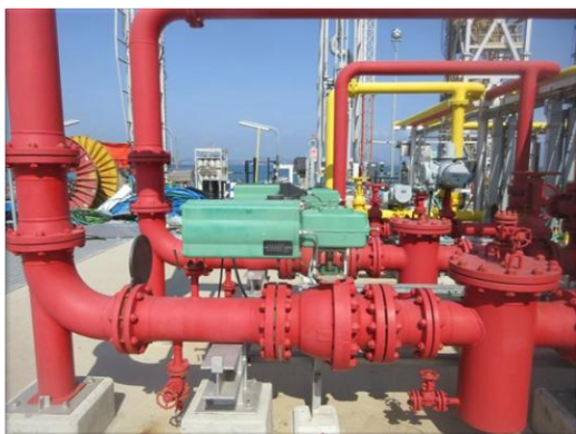
รูปที่ 2-37 วาล์วน้ำหล่อเย็นแบบเปิดอัตโนมัติเมื่อไฟไหม้ (Deluge valve system)
