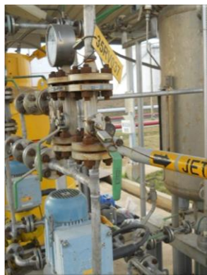
รูปที่ 2-35 Lock-out Mercaptan Injection Pump
