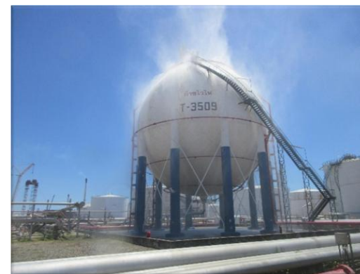
รูปที่ 2-38 ระบบน้ำฝอยหล่อเย็น (water spray system)
