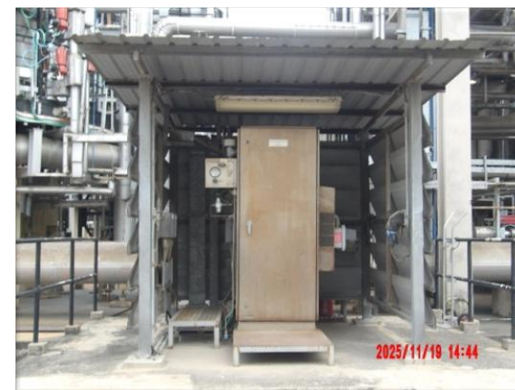
รูปที่ 2-2 ระบบตรวจสอบคุณภาพอากาศแบบต่อเนื่อง (CEMS)
